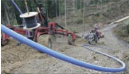
Abb.3: Einsatz des Rohr- und Kabelpflugs
