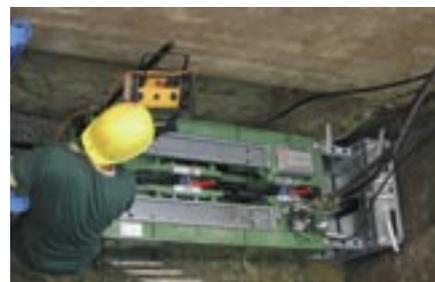
Abb.2: Einsatz Grundoburst für die Rohrerneuerung
