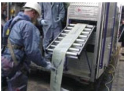
„Imprägnierung eines Hausanschlussliners mit einer mobilen Tränkungsanlage“
