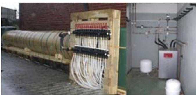
Abb. 1: Anschlussmontage Wärmetaucher.
