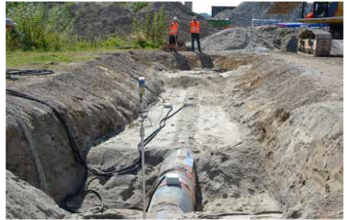
Bild 3: Verfüllung und Setzen weiterer Sensoren
