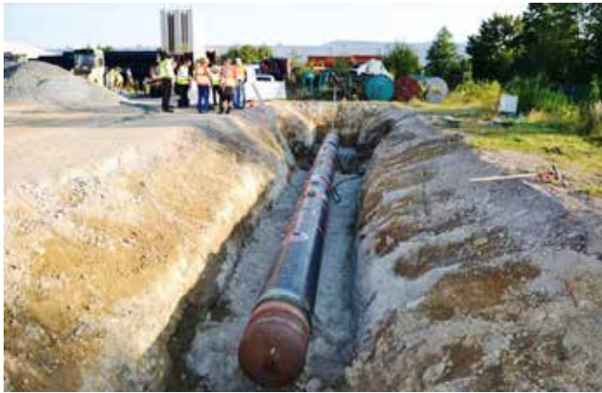
Bild 2: Rohrgraben und mit Sensorik versehenes Stahlrohr zu Versuchsbeginn
