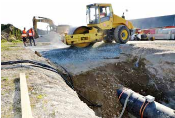
Bild 4: Walzenzug zur Verdichtung des Straßenunterbaus
