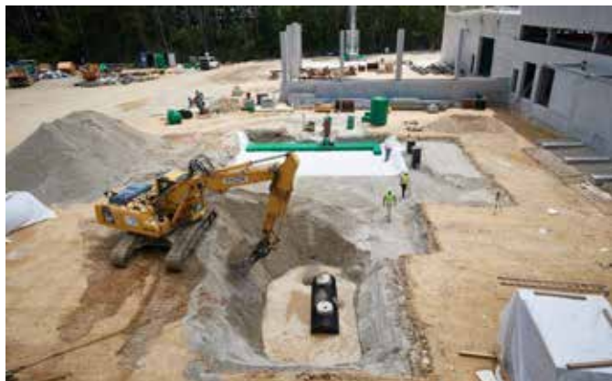
Einbau des Regenwassermanagementsystems
