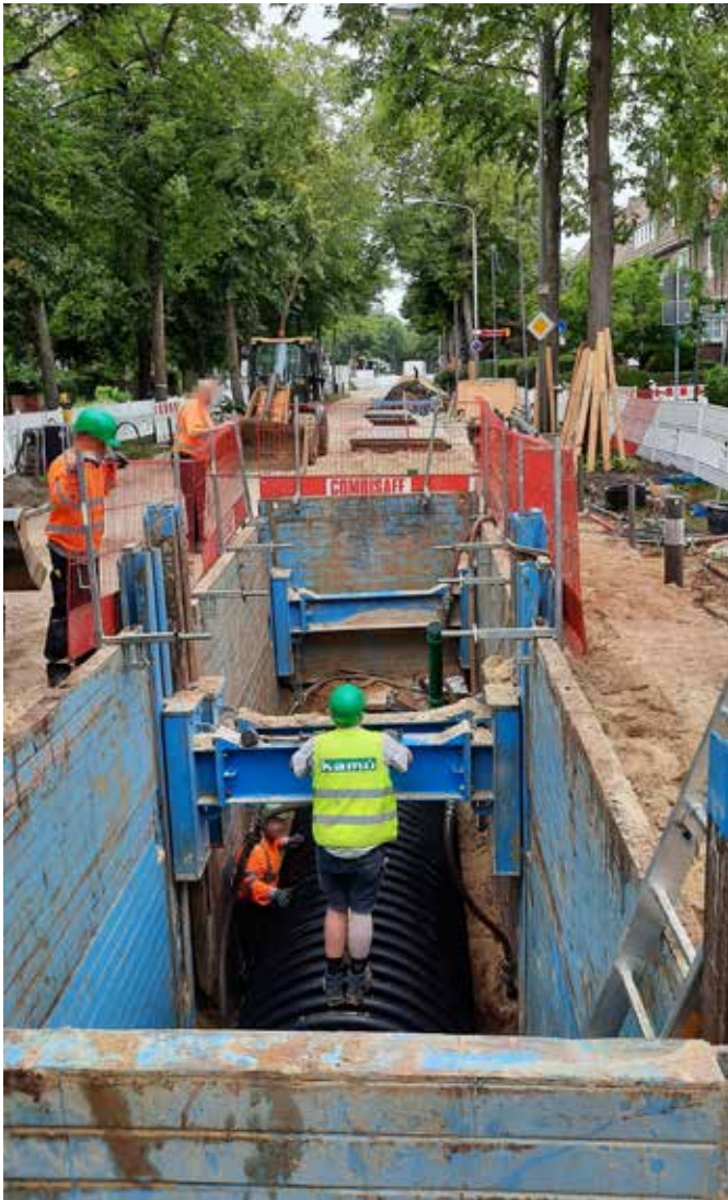
Mit der Instandhaltung der Kanalisation übernehmen wir Verantwortung für nachfolgende Generationen.
