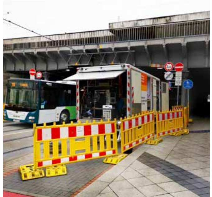
Einsatz des TV-Wagens zur Inspektion des öffentlichen Sammlers mit Anschlussleitungen außerhalb des Bahnhof
