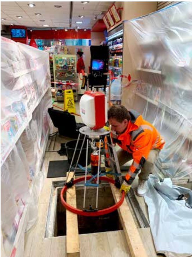
Einsatz der Schachtkamera im Ladenbereich
