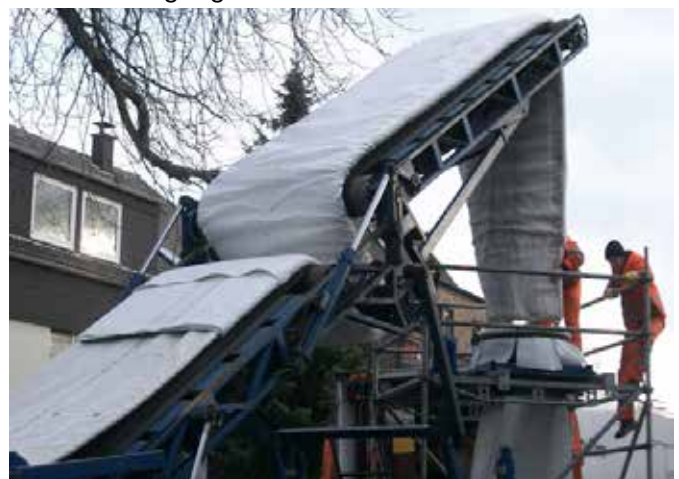
Renovierung durch Inliner
