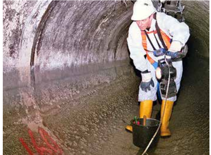
Optische Inspektion durch Begehung
