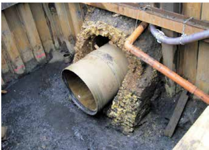
Renovierung durch Rohrlining
