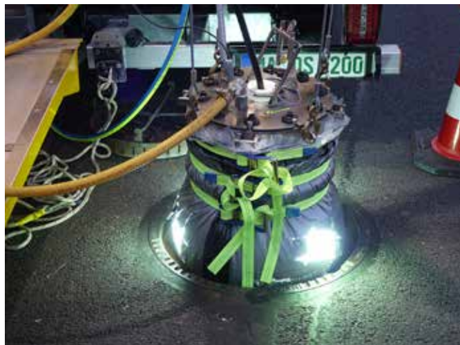
Das lichthärtende Schlauchlining wird bereits seit einigen Jahren erfolgreich in der Kanalsanierung eingesetzt. Seit vergangem Jahr wird das Verfahren auch vermehrt zur Instandsetzung von Schächten genutzt.
