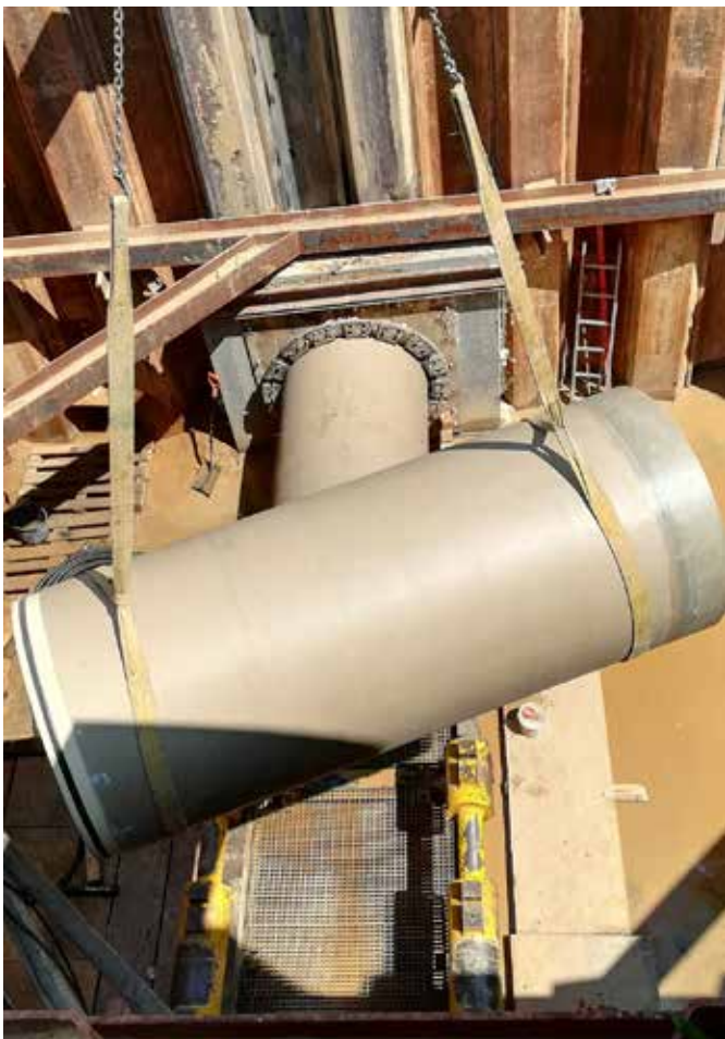
Grabenloser Leitungsbau ist auch beim Bau neuer Abwasser-systeme gefragt. In diesem Fall handelt es sich um eine Vortriebsbaumaßnahme mit GFK-Vortriebsrohren.
