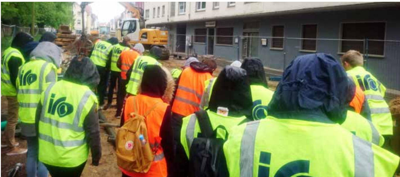
Studierende der Vorlesungen Rohrleitungsbau und Sanierung von Rohrleitungen auf Baustellenbesichtigung (Blick von außerhalb der Baustelle)
