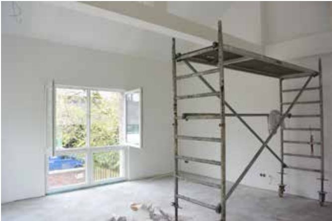
Blick in den Sozialraum nach Malerarbeiten
