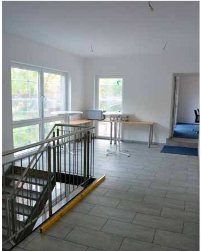
Der fast fertige Zwischenbau
