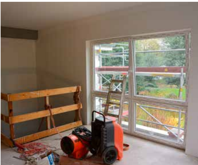
Vorraum bzw. Treppenhaus im 1. Obergeschoss (Verbindungsbau) nach Malerarbeiten
