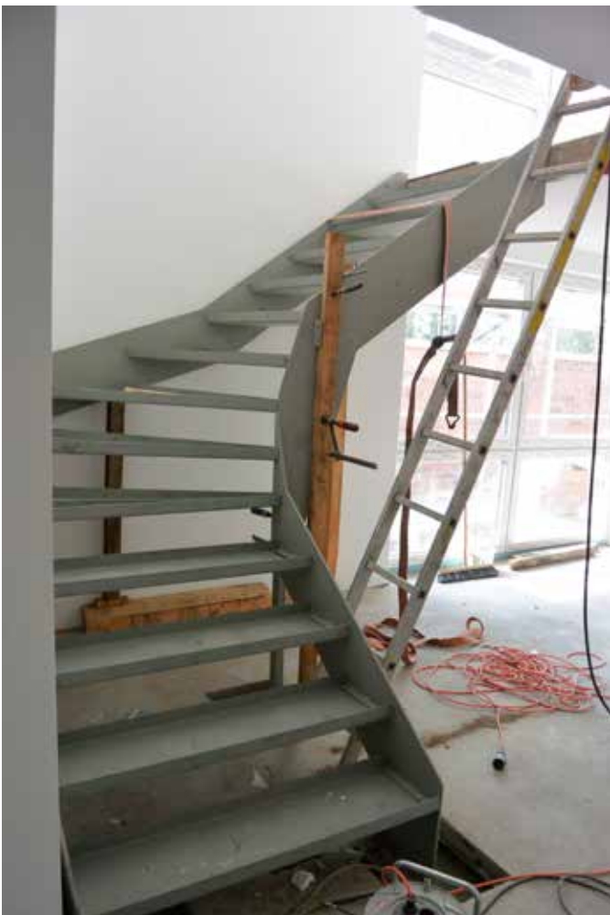
Einbau der Treppe im Zwischenbau Mitte April
