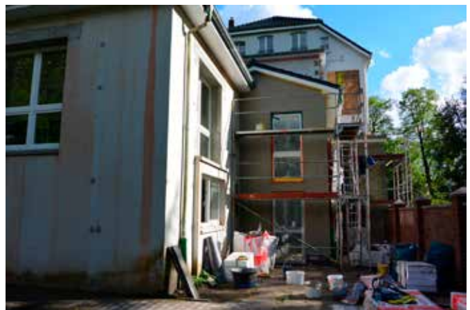
Außendämmarbeiten
