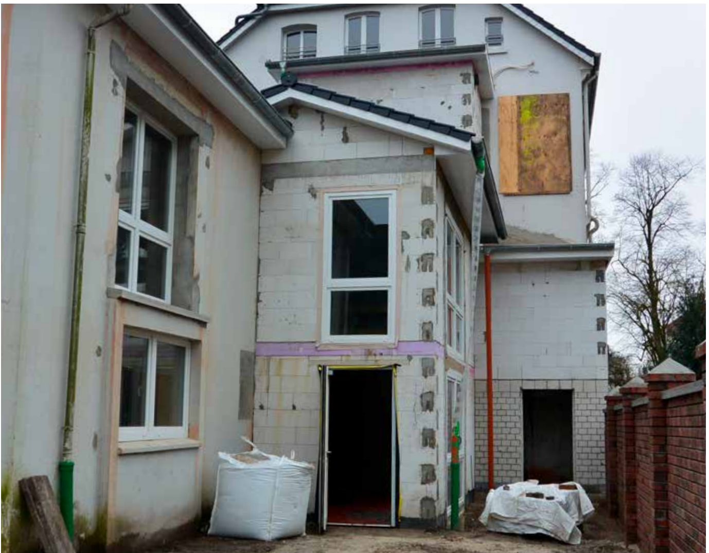
Rückwärtige Gebäudeansicht Anfang März 2018. Hier fehlt noch das Wärmeverbundsystem für den Verbindungsbau und der neue Anstrich der alten Gebäude.
