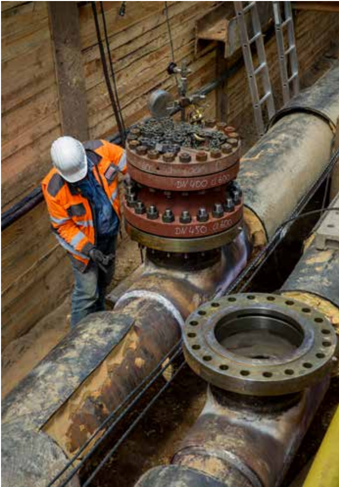
Fernwärmenetzumschluss BHKW Hamburg Stapelfeld.
