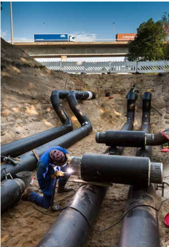
Arbeiten an der Fernwärmeleitung Eurogate Hamburg. Foto: STRABAG AG, Bereich Nordhorn
