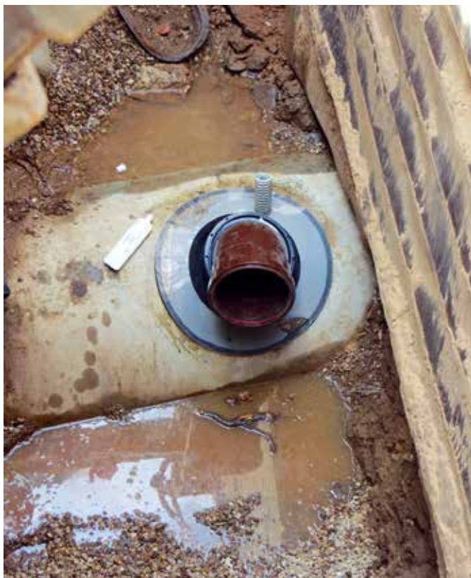
Sauber saniert, dauerhaft dicht: Mit dem in mehreren Ausführungen erhältlichen Funke-Sanierstützen lassen sich Ausbrüche von 200 bis 310 mm professionell sanieren.
