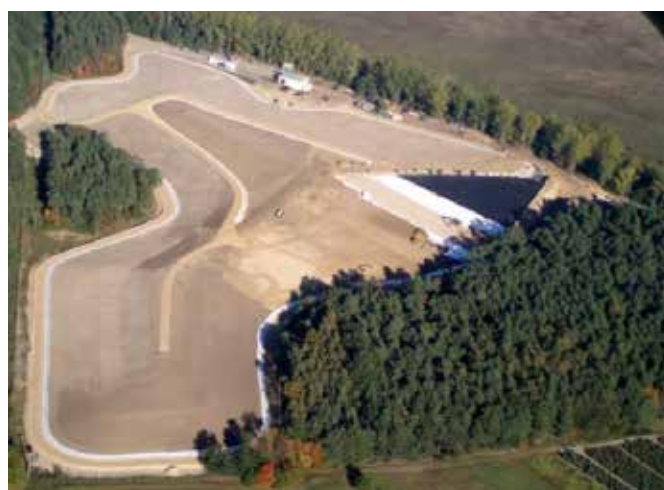
Sicherung / Rekultivierung Deponie Strüwe
