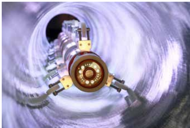
Sanierung mittels GFK-Schlauchliner. Lichtquelle 8x400W in einem Liner DN 300.
