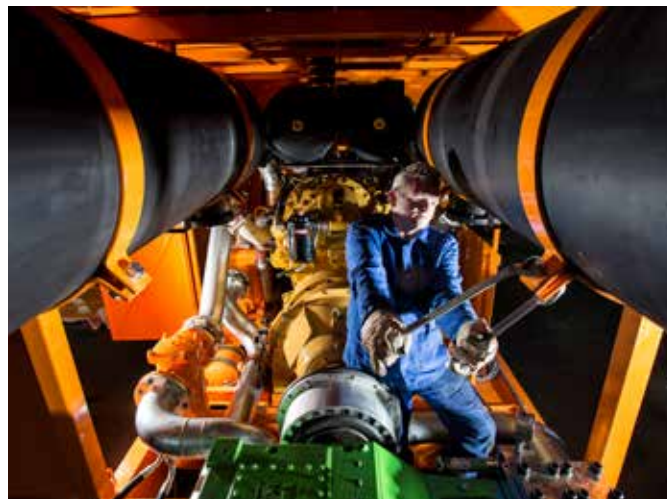
Anlagenbau Foto: FRIEDRICH VORWERK KG (GmbH & Co.)
