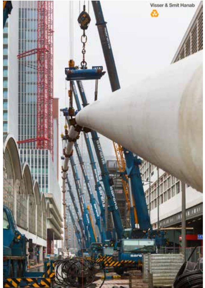
Eine 1500 m lange Stahl in Stahl Fernwärmeleitung AD 600 mm wird mitten im Zentrum von Rotterdam von 22 Kränen auf 14m Höhe gezogen. Foto: Visser & Smit Hanab bv
