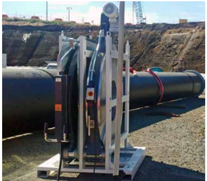
Abwasseraufbereitungs-Projekt: Einsatz einer leistungsstarken HÜRNER Stumpfschweißmaschine WeldControl 1600 – professionelles Stumpfschweißen von Kunststoffrohren der Größe 800 - 1600 mm. Foto: HÜRNER Schweisstechnik GmbH
