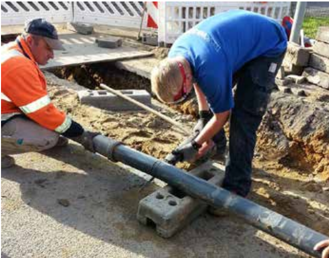
Abbildung 2: Rohrprobenentnahme an einer Gasversorgungsleitung
