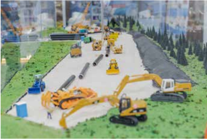
Abb. 4: Mutterbodenabtrag und Rohrausfuhr
