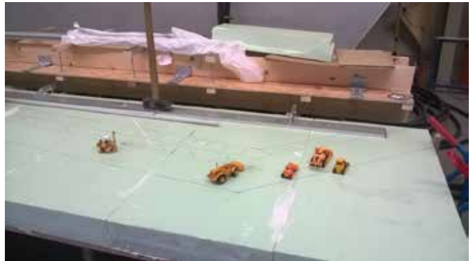
Abb. 1 Verkleben der Dämmplatten / Anreißen der späteren Trasse
