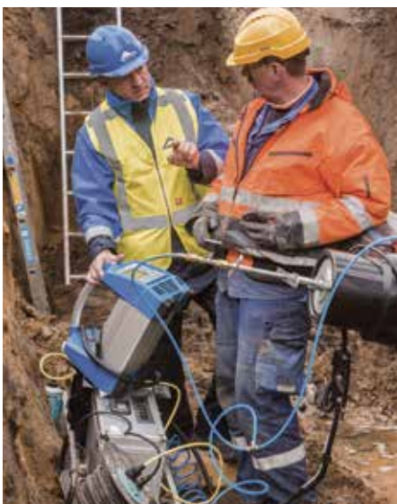
Bild 2: Einbringen des Reparaturballons
