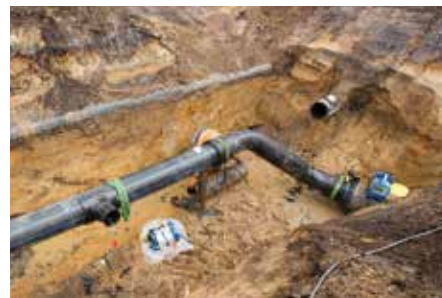
Bild 5: Einbau Etage-Bogen d 355 / 45°
