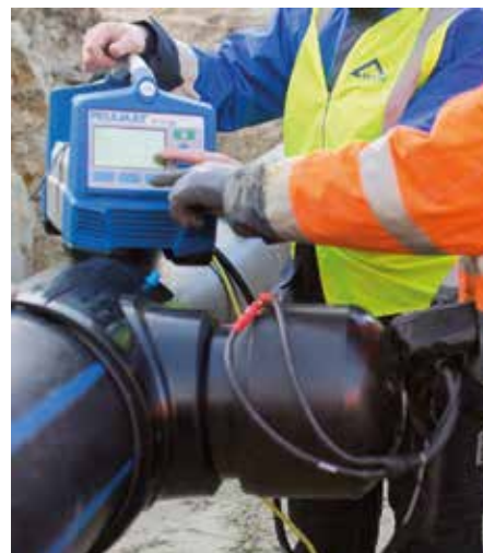
Bild 6: Schweißung Verschlussmuffe
