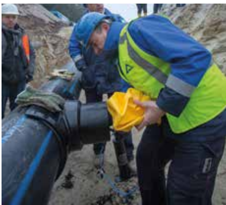
Bild 2: Einbringen des Reparaturballons
