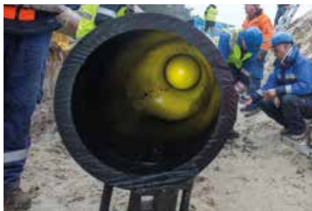
Bild 3: Der Reparaturballon dichtet im Rohr gegen nachfließendes Wasser ab.
