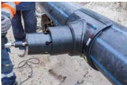
Bild 1: Anbohren der Leitung durch die Stutzenschelle SA XL d 355 / d 225
