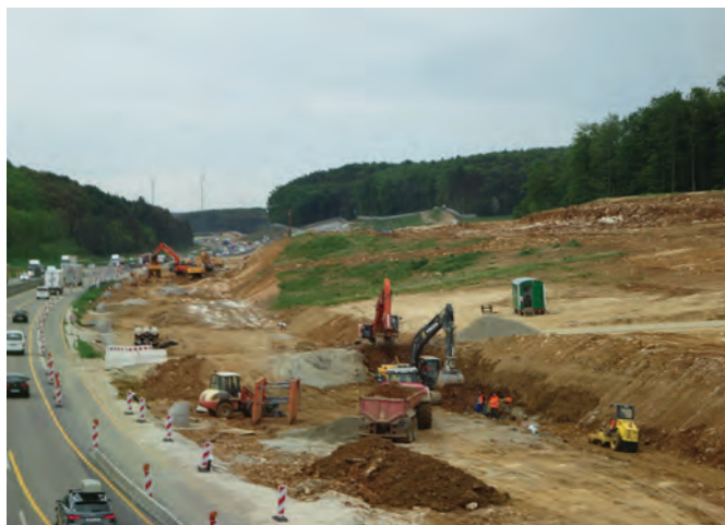
Bunte baut den Alabastieg: Autobahnausbau und ICE-Trasse Stuttgart/Ulm
