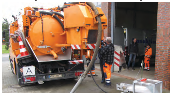
Abbildung 3: Prüfdurchführung auf dem Betriebsgelände der TBW
