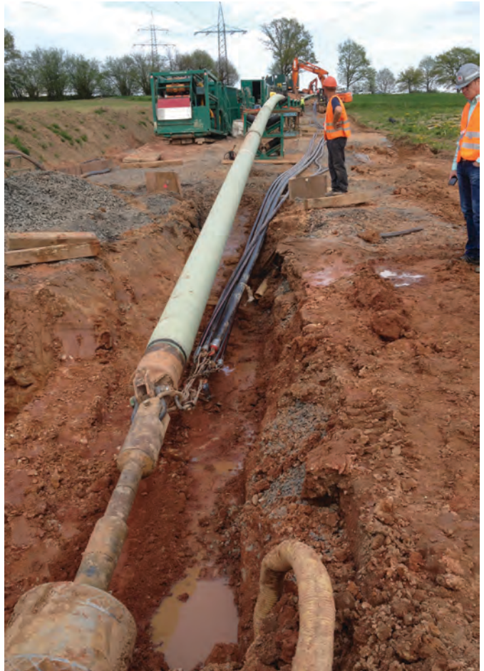
Stahlrohreinzug glasfaserverstärkt mit Begleitrohren. (Foto: Beermann Bohrtechnik GmbH)
