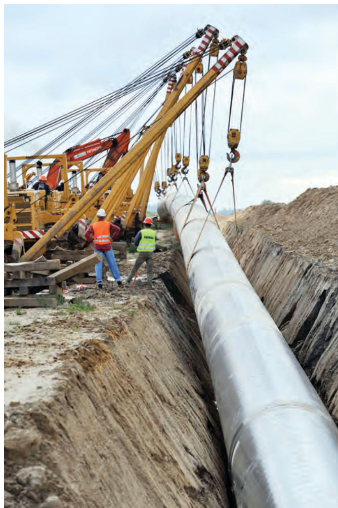
Opalleitung – Absenken der Leitung. (Foto: Pipeline Systems GmbH)
