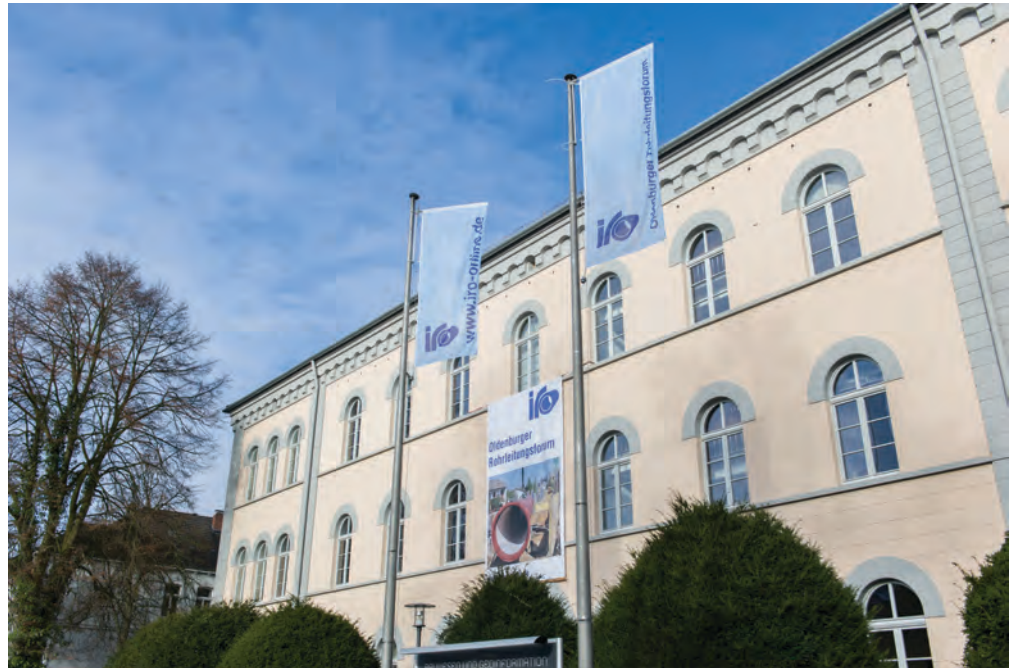
„Dumme Rohre – Intelligente Netze“ lautet das Motto des 30. Oldenburger Rohrleitungsforums, das am 11. und 12. Februar 2016 auf dem Gelände und in den Räumen der Jade Hochschule stattfinden wird. (Foto: iro)
