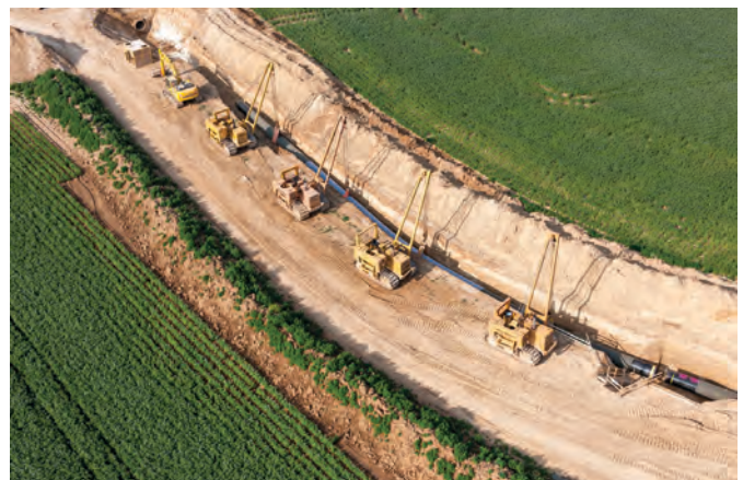
Haute de France II Projekt, 51,7 km Pipeline, DN 1200, Frankreich. (Foto: MAX STREICHER GmbH & Co. KG aA)
