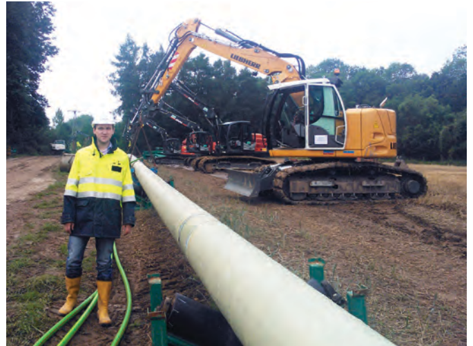
Mantas Vasiliauskas auf der Baustelle...
