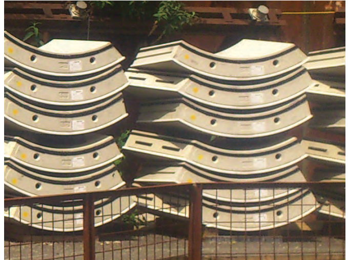
Tübbinge vor dem Einbau
