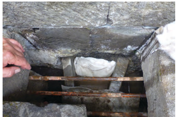
Filtersack zum Schutz vor dem Eintrag von Sedimenten in den Kanal
