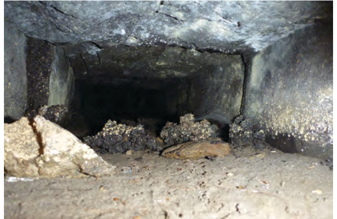
Blick in einen Filterkanal
