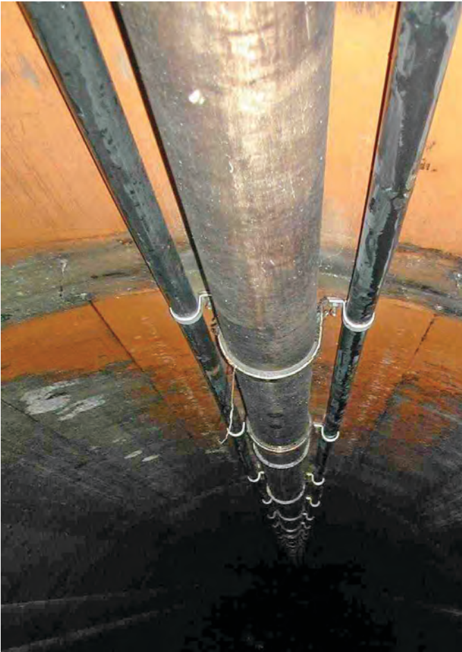
Seit 15 Jahren werden in Hamburg Lichtwellenleiter in Abwasseranlagen verlegt. (Foto: servTEC - HAMBURG WASSER Service und Technik GmbH)
