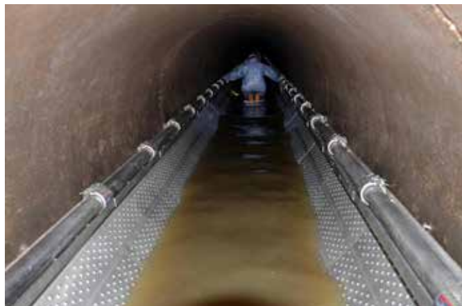
Baustellensituation im Kanal
