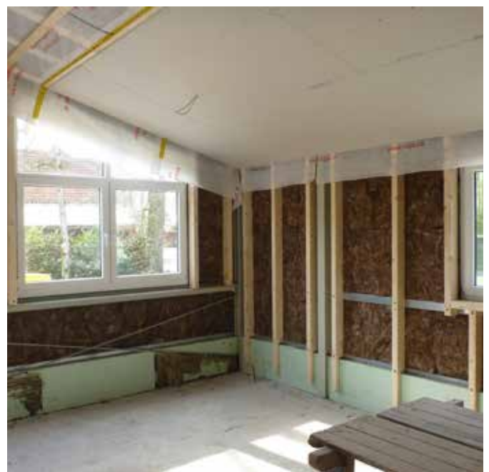
Der Innenausbau nimmt Gestalt an
