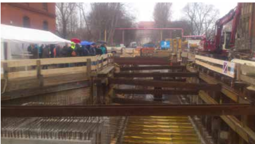
Baustellenbesuche „Schaustelle“ im Rahmen der Wasser Berlin International 2015
