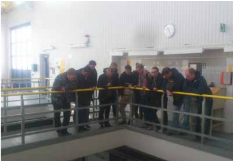
Studierende der Jade-HS sowie Herr Kersten von den Berliner Wasserbetrieben im Pumpwerk an der Holzmarktstraße in Berlin
