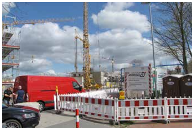
Baustellensituation an der Oberfläche
