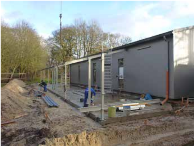
Aufstellen der Stahlkonstruktion
