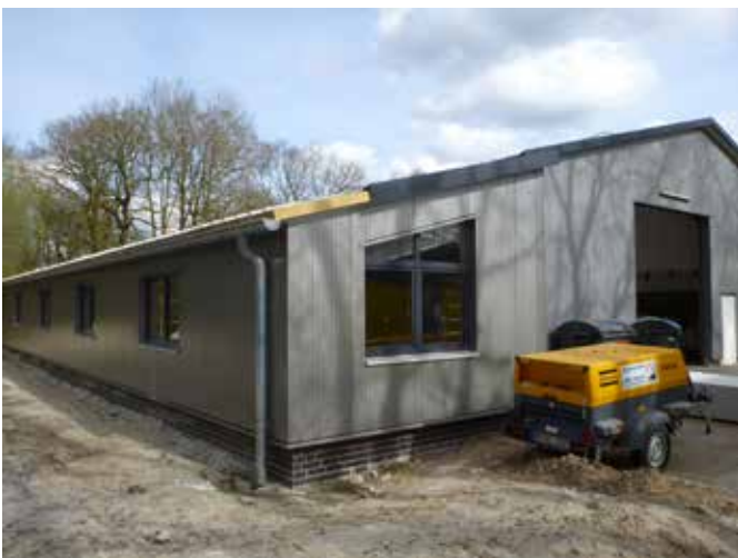
Wand- und Deckenverkleidung sowie Fenster sind montiert
