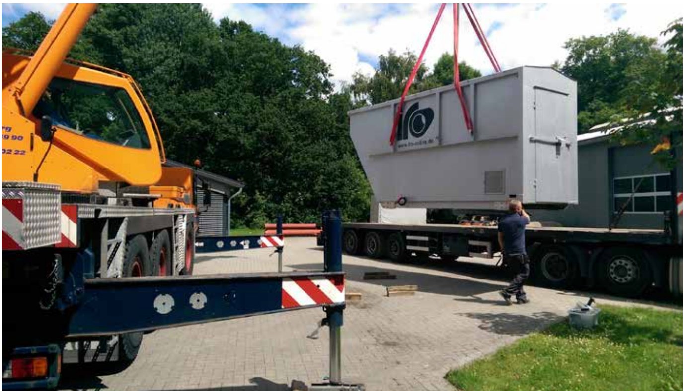
Verladen des Messcontainers bei der iro-Forschungshalle
