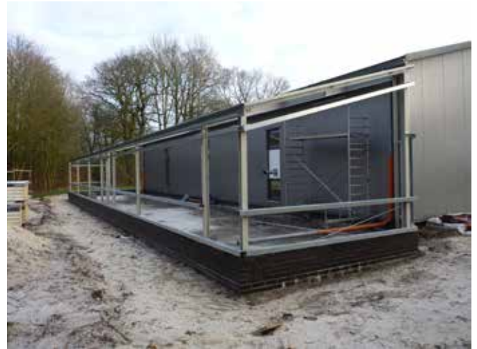
Fertige Stahlkonstruktion mit Sockelmauerwerk
