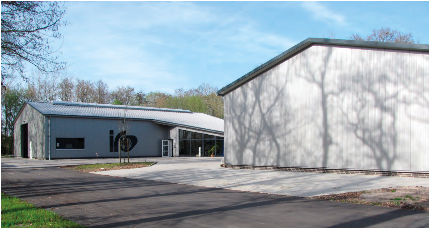
Forschungshalle (hinten) und Lagerhalle (vorne)
