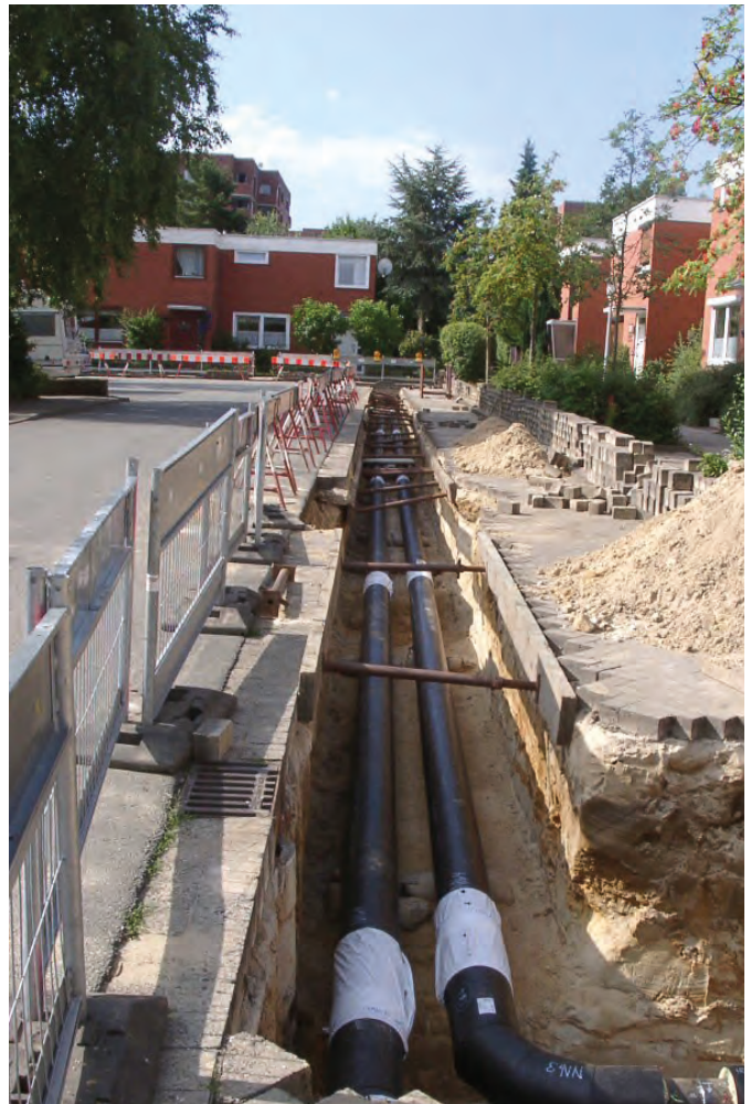
Typisches Bild einer Fernwärme-Baustelle mit Vor- und Rücklaufleitung ausgeführt in Kunststoffmantelrohren
