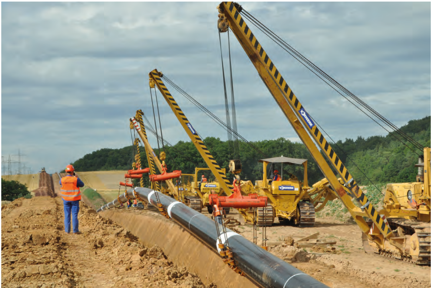
Technische Kompetenz beim Bau des MIDAL Südloop 2013
