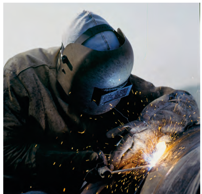
Rohrverschweißung an der WEDAL: 20.000 Schweißnähte für 320 km Leitung Foto: GASCADE Gastransport GmbH
