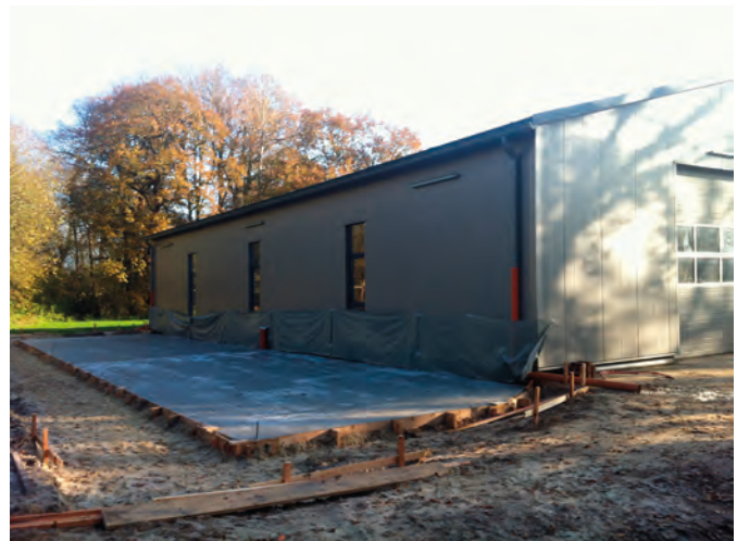
Anbau Labortrakt: Fertige Betonplatte
