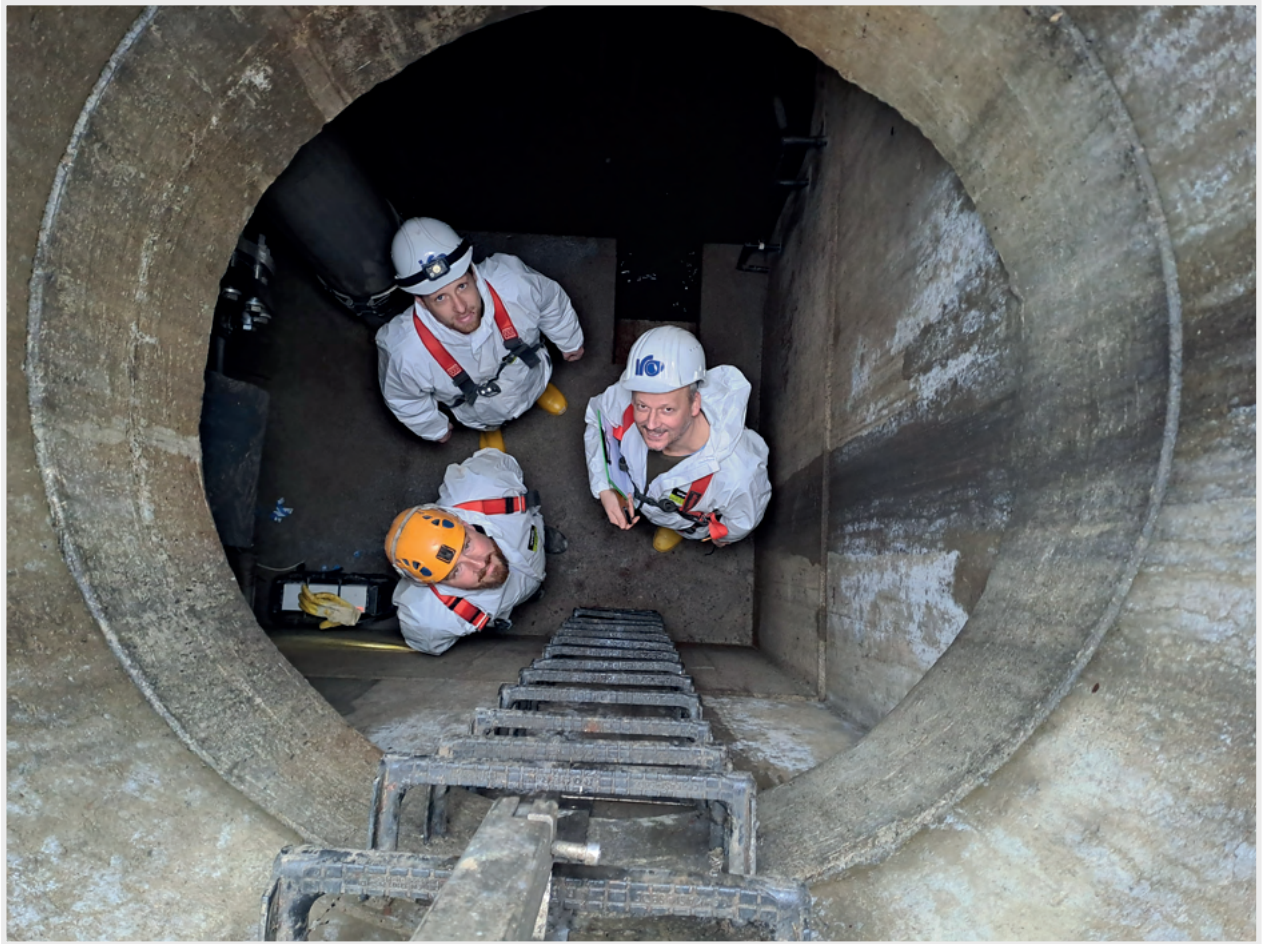
Christian Bechler, Malte Schoon und Mike Böge nach dem Schachteinstieg
