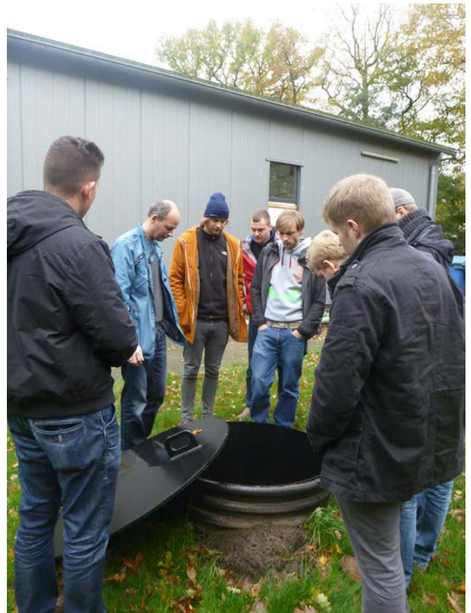
Ein Blick in den Kanalschacht – Bestandteil des zu erhaltenden Rohrsystems
