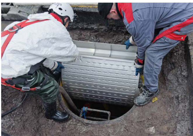
Einbringung der einzelnen Module durch den Kanalschacht. Foto: iro
