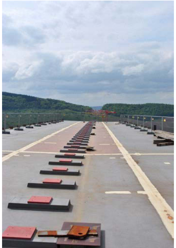
Hochmoselbrücke bei Zeltingen: Blick vom ersten Element des Überbaus zur gegenüber liegenden Moselseite
