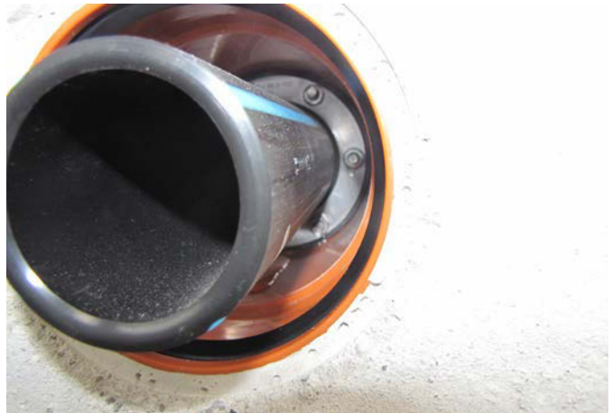
Bild 2: Installierter Dichtungseinsatz im Prüfaufbau
