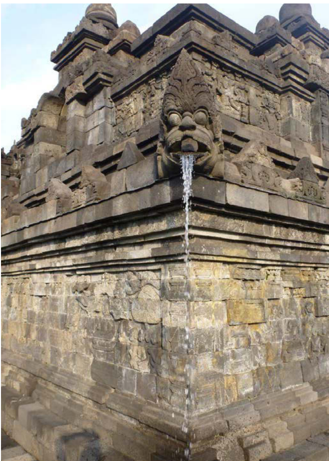
Abb. 1: Wasserspeier mit simuliertem Regenwasserabfluss
