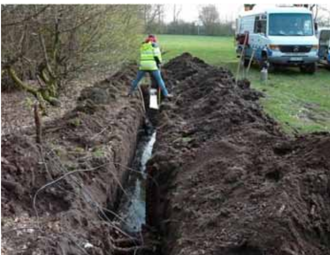
Einmessen eines Anodenfeldes
