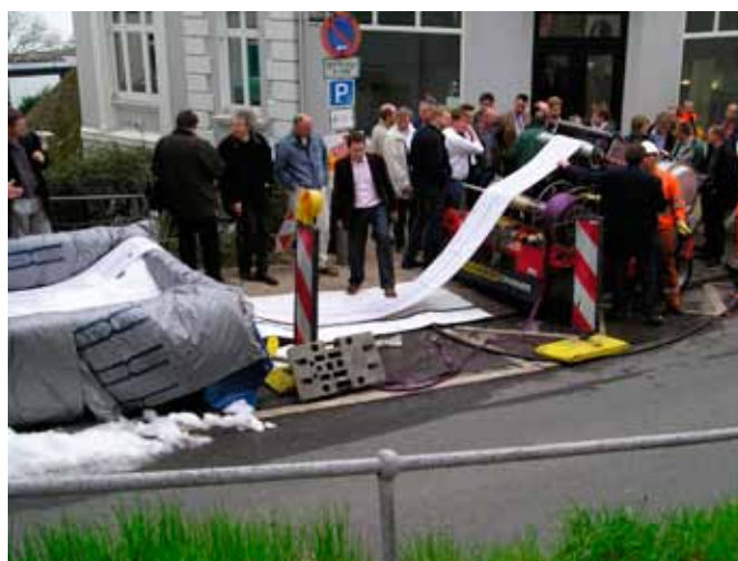
Sanierungssystem mit Dampfhärtung in Blankenese 2008
