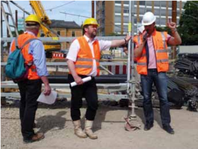
Tunnelbau in Karlsruhe – Bauleiter und Exkursionsleiter unter sich
