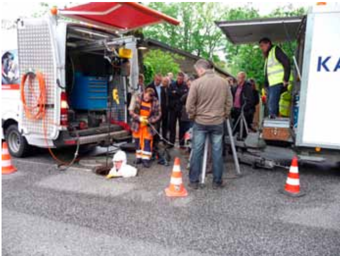
Zusammenbau des Robotersystems im Schacht 2011
