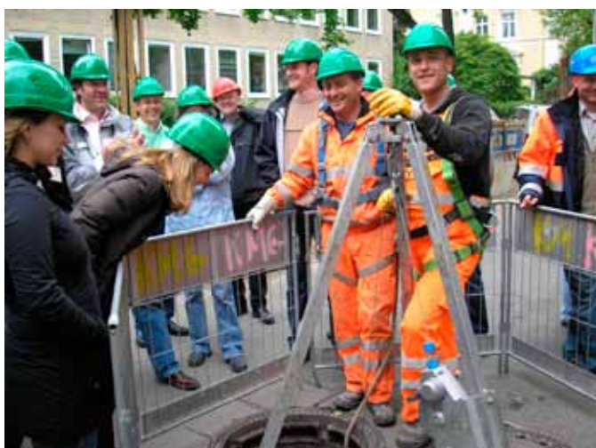
Gute Laune auf der Baustelle 2009
