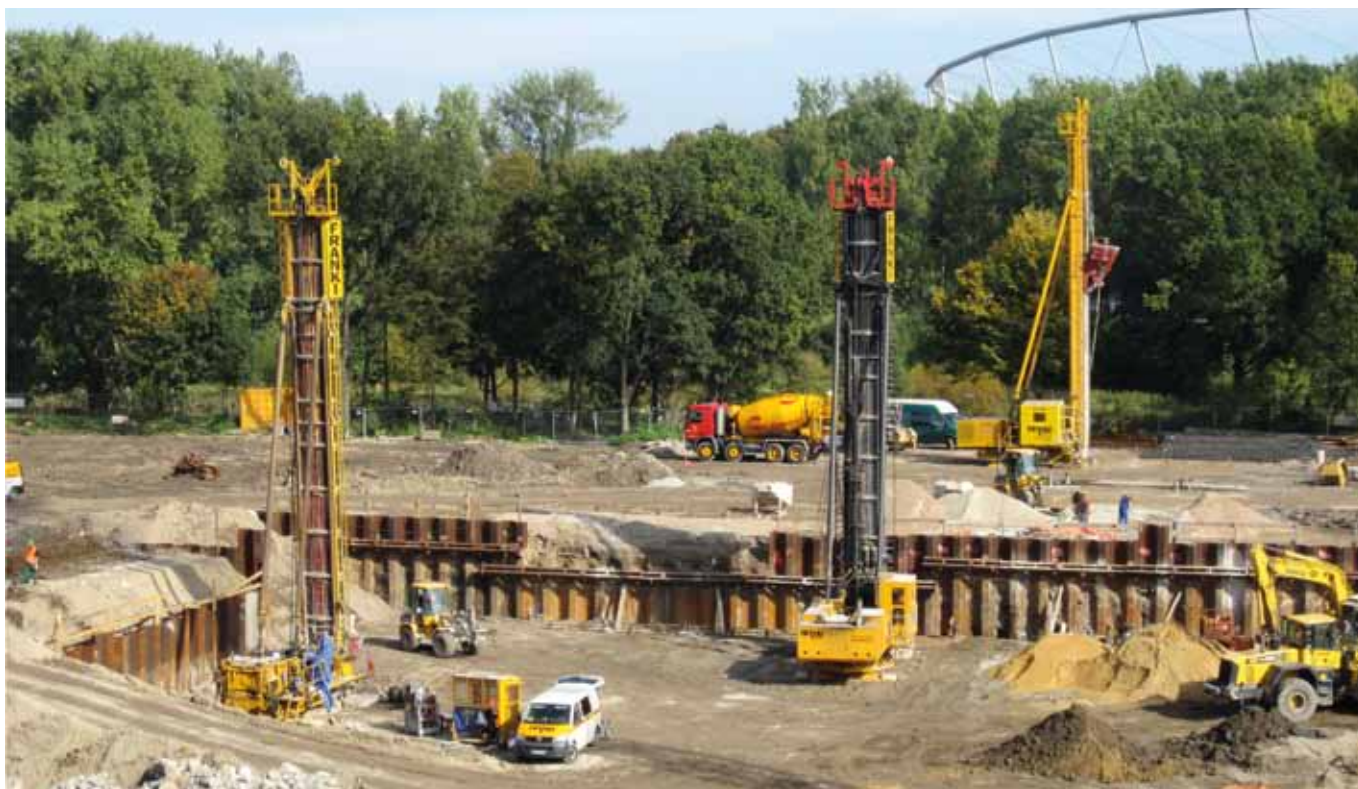
Pfahlgründung – Drei FRANKI-Rammen gleichzeitig im Einsatz
