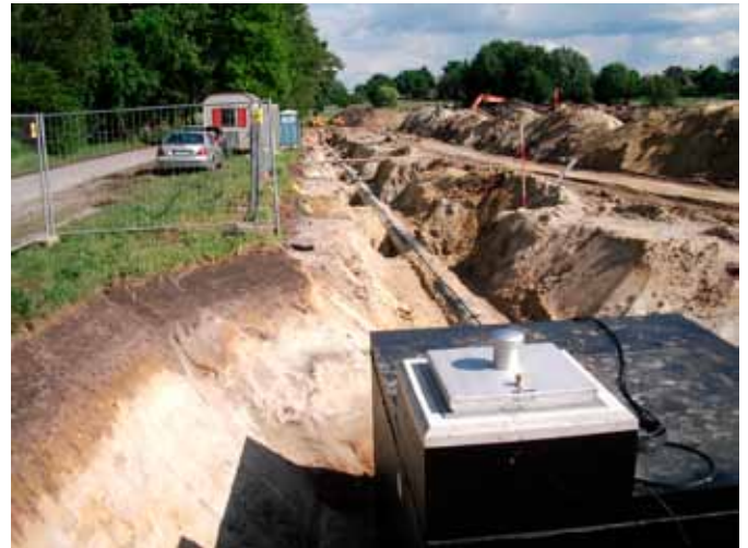
Neuerlegung einer Rohrleitung mit Korrosionsschutz
