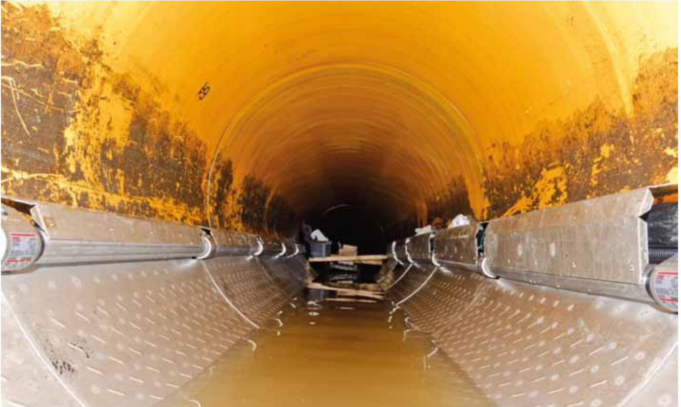
Abbildung 1: Rinnenwärmetauscher während des Einbaus
