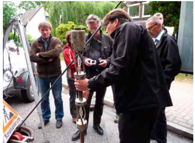
Funktionsweise der UV-Lichtquelle für das lichterhärtende GfK-Schlauchlining 2011
