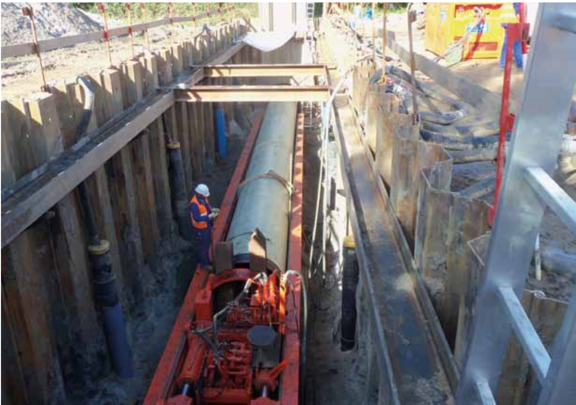
Ausführung einer Querung im Bohrpressverfahren
