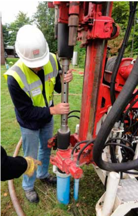
Einbau des Entsandungsseiher mit dem Bohrgerät DSB 0.
