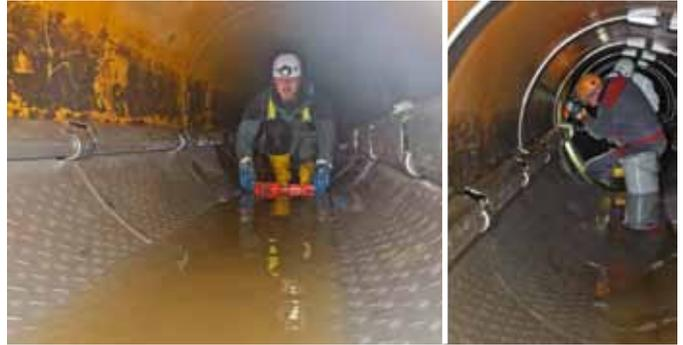
Abbildung 4: eingebaute Module ohne und mit Verspannung
