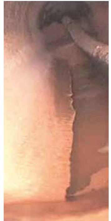
*Typisches Schadensbild: Rohrsohle ausgespült, Steinzeugrohr, industrielles Abwasser
