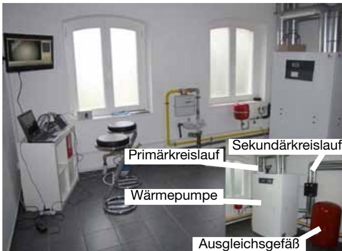
Abbildung 1: Die Heizzentrale des iro-Gebäudes
