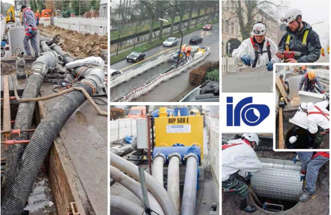
Abbildung 3: Vorbereitung und Einbau der Wärmetauschermodule
