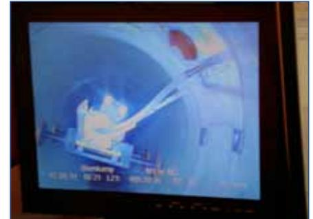
Verpressung von Epoxidharz in die Schalungsmanschette für die Anbindung des Einlaufs an den Inliner DN 800
