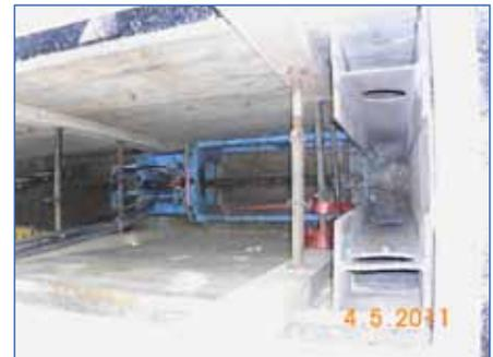
– 200 in grabenloser Bauweise erneuert werden. Zusätzlich zu diesem Verfahren und um einen Unterschied zur ersten Baustelle deutlich zu machen, wurde hier das Hilfsrohrverfahren eingesetzt.
