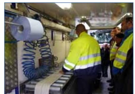
Computergesteuerte Imprägnierung eines Hausanschlussliners auf der Baustelle
