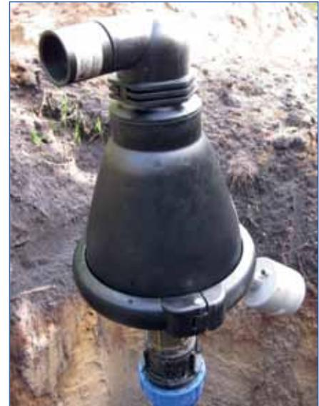
Abb. 1 Montiertes Entlüftungsventil mit Datenlogger.
