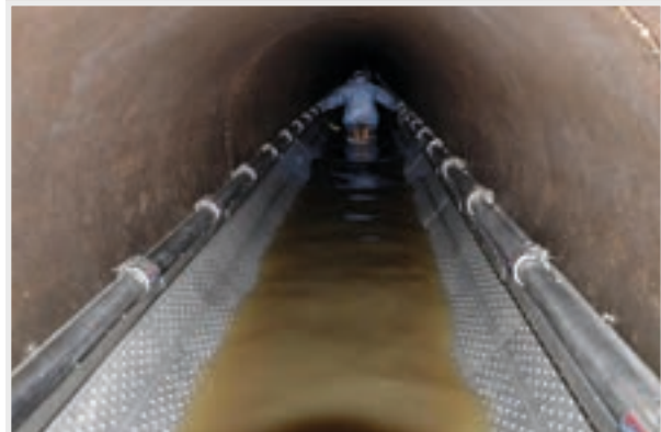
Abbildung 3: Einbau der Abwasserwärmeübertrager im Quartier „Alter Stadthafen“
