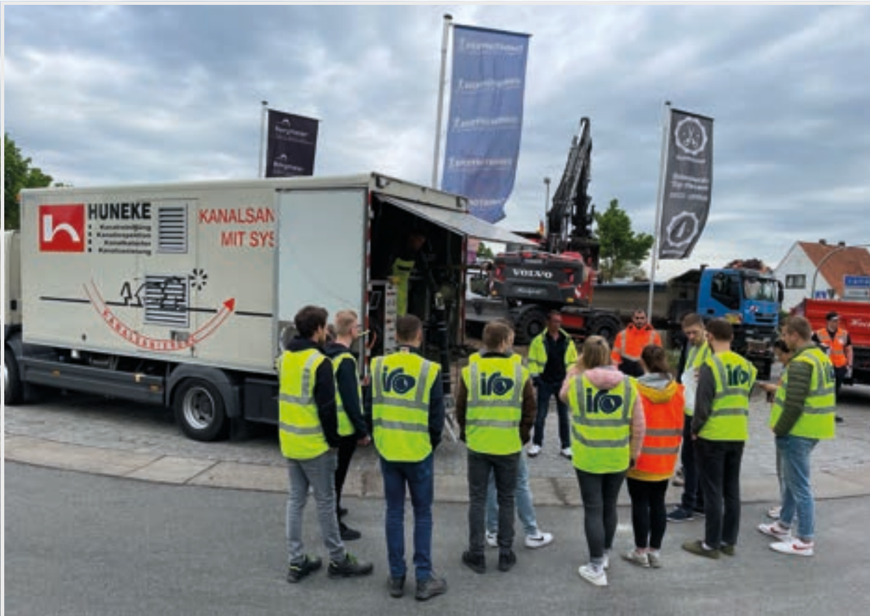
Sascha Tietjendiers, Huneke Kanalsanierung erklärt den Studierenden den Einsatz von unterschiedlichen Roboterverfahren im Zuge einer Linerbaustelle
