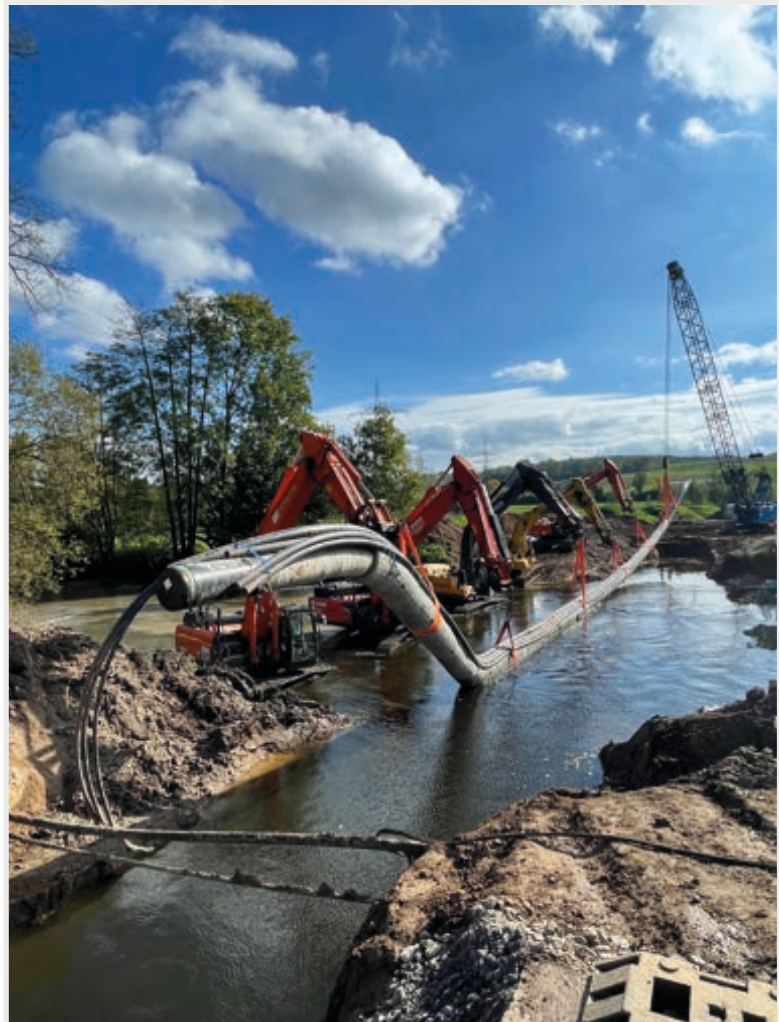
Einbau des Dükers in der Enz in offener Verlegung
