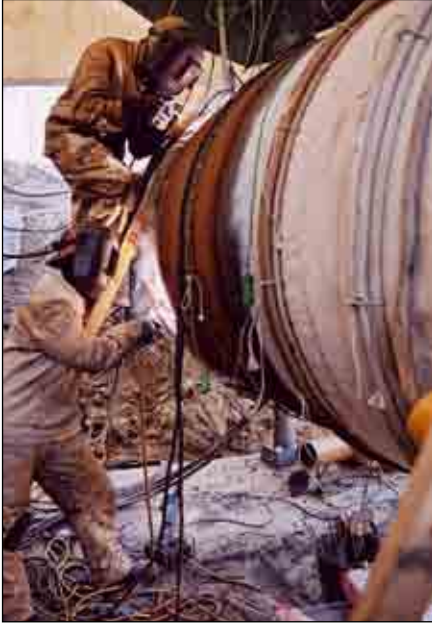
Schweißarbeiten an einer in Betrieb befindlichen Gasleitung
