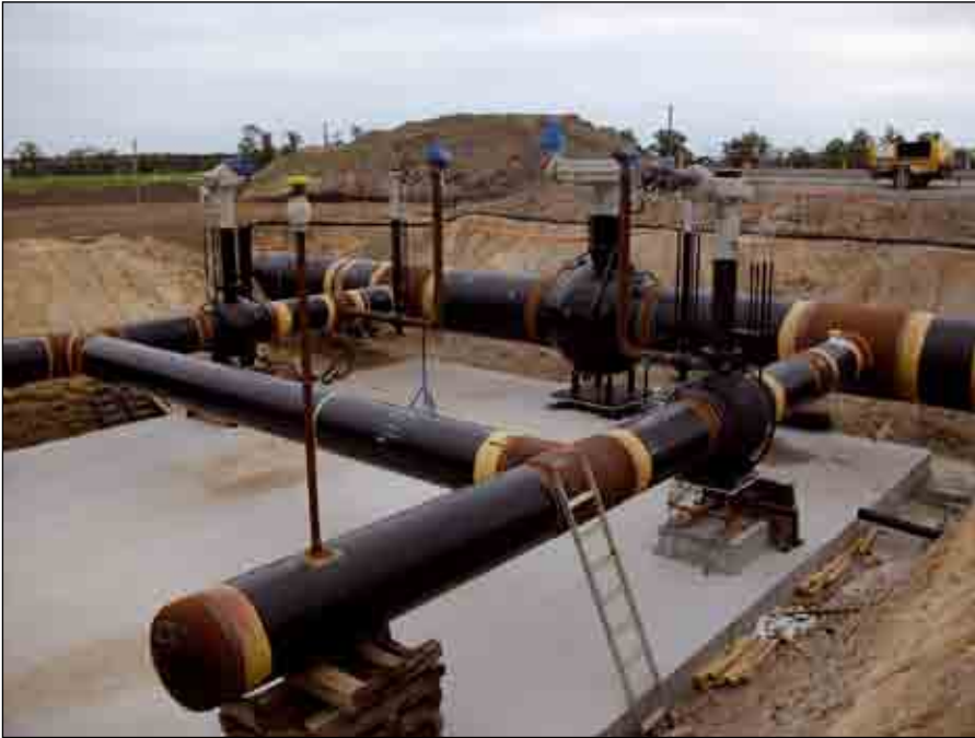
Stationsbau im Pipelinebau - Schiebergruppe
