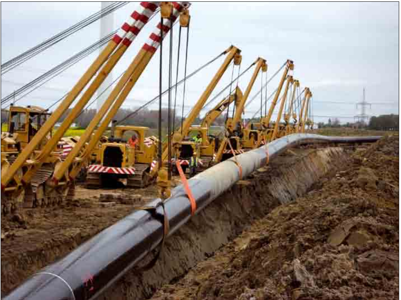
Seitenbäume beim Absenken der Rohrleitung
