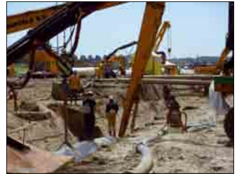
Projekt: 48 Zoll Gaspipeline, Gesamtlänge 500 Kilometer Im Bild: Unterquerung einer Nebenstraße in offener Bauweise, freigelegte Abwasser- und Versorgungsleitungen sowie ein Schwerkraftbrunnen (rechts im Bild), Vermesser und Schweißtrupps (links im Bild)
