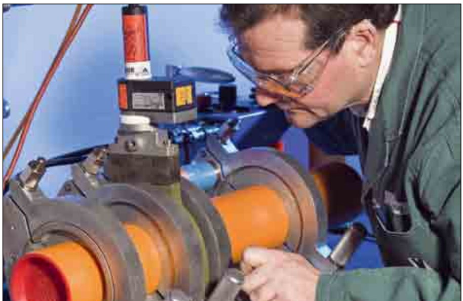
Vorführung einer fachgerechten Heizelementstumpfschweißung an einem Rohr aus PE 100
