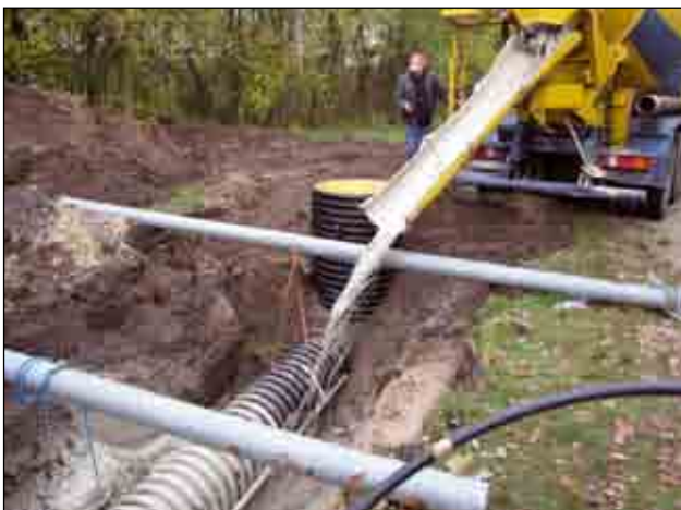
Abbildung 1: Einbau des geothermischen Verfüllbaustoffes
