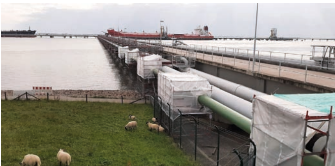
GU Auftrag für den Bau einer 24“ Leitung in Wilhelmshaven
