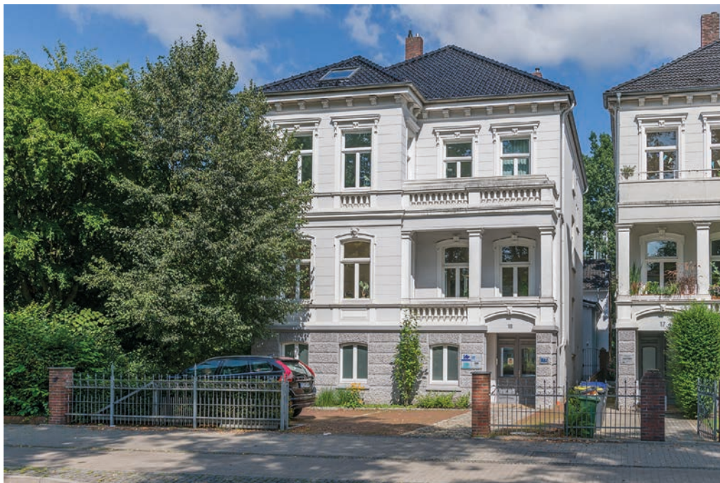
Seit geraumer Zeit bilden das Zentrum für Weiterbildung (ZfW) und das Institut für Rohrleitungsbau (iro) der Jade Hochschule eine räumliche Einheit.
