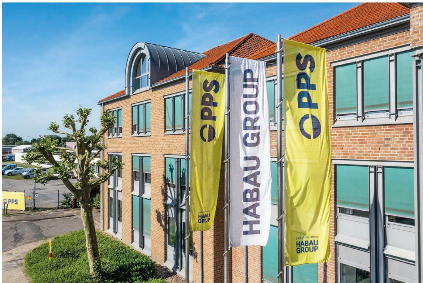
Zentrale der PPS in Quakenbrück
