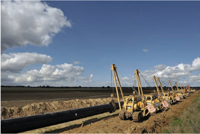
Bau der EUGAL, Lose 1 und 2
