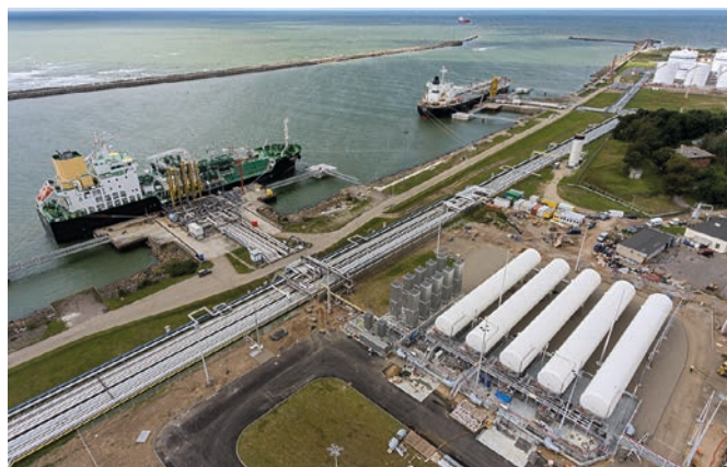
LNG Speicher- und Verladestation im Hafen von Klaipeda, Litauen.
