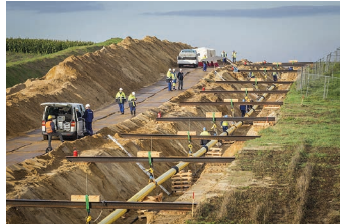
Tieferlegung einer Gasleitung in Engersen bei laufendem Betrieb
