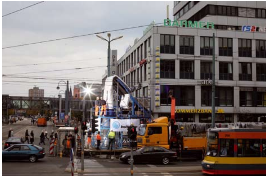
Heute: Inversion eines Liner DN 1600 im Frankfurter (Oder) Stadtzentrum
