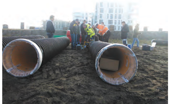
Abbildung 3: Herr Bruns (Frank GmbH) demonstriert den Schweißvorgang für eine Rohrverbindung von großprofiligen Kunststoffrohren auf einer Bremer Baustelle
