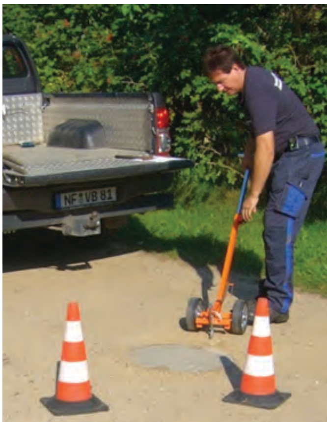
Schachtbegehung im Rahmen der Verifizierung
