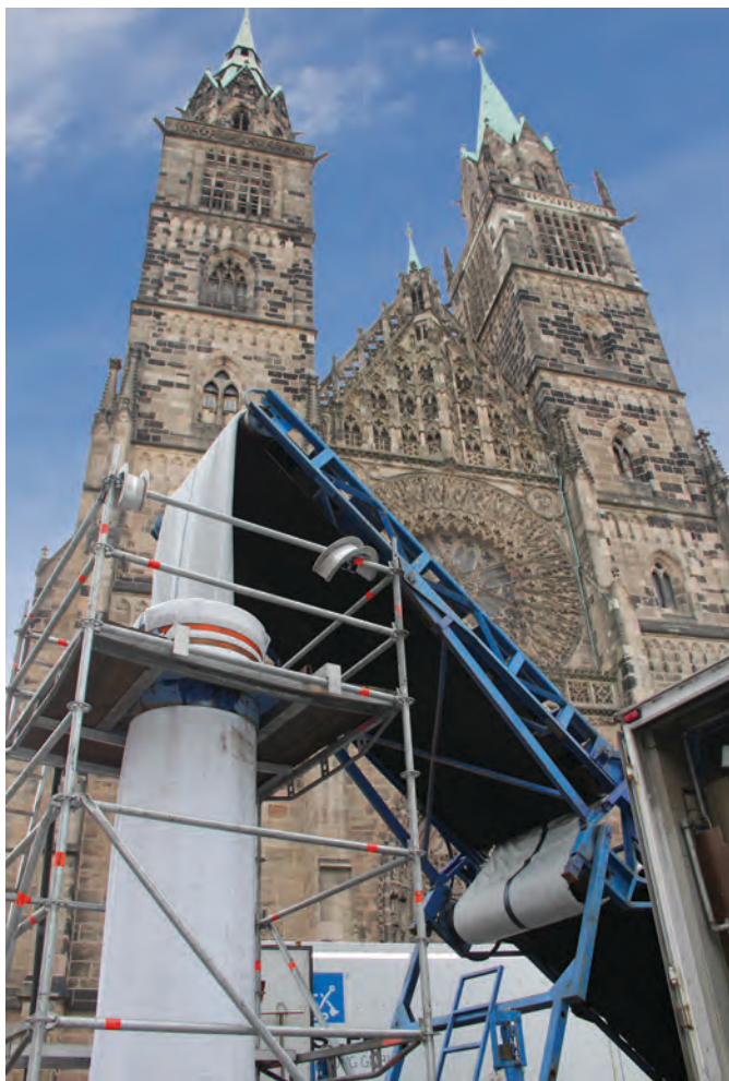
Grabenlose Kanalsanierung
