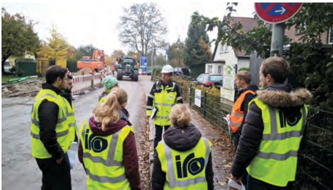
Abbildung 1: Herr Goral, OOWV, präsentiert den Studierenden der Jade-Hochschule eine Oldenburger Kanalbaustelle in offener Bauweise
