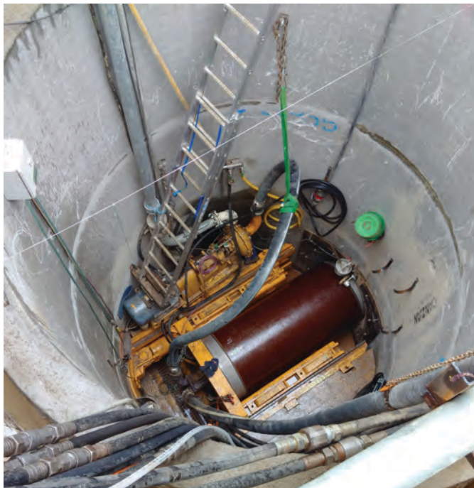
Grabenlose Bauweisen – ein Dauerbrenner in Oldenburg; Pressgrube mit Steinzeugrohr (Foto: Steinzeug Keramo)
