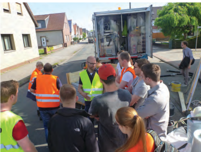
Abbildung 2: Linerbaustelle in Delmenhorst, Herr Schütt (D&S) erklärt den Studierenden die Technik
