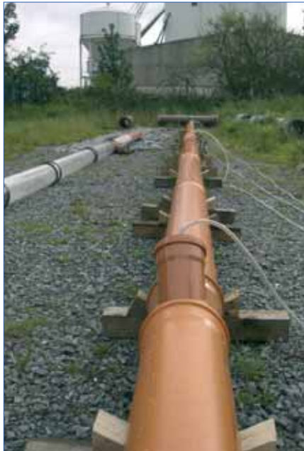
Abb: Versuchsstrecke auf altem Gelände
