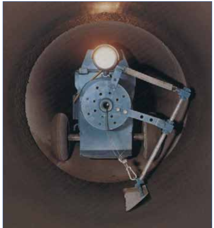
Zementmörtelauskleidungsmaschine
