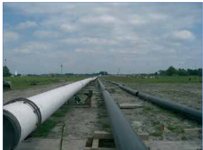
Abb. 2.: Geschweißte Rohrleitungen, Vorbereitung zum Einzug
