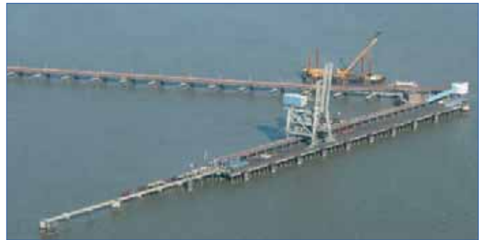
Luftaufnahme der Niedersachsenbrücke, unter der die Sohlsicherung ausgeführt wird.
