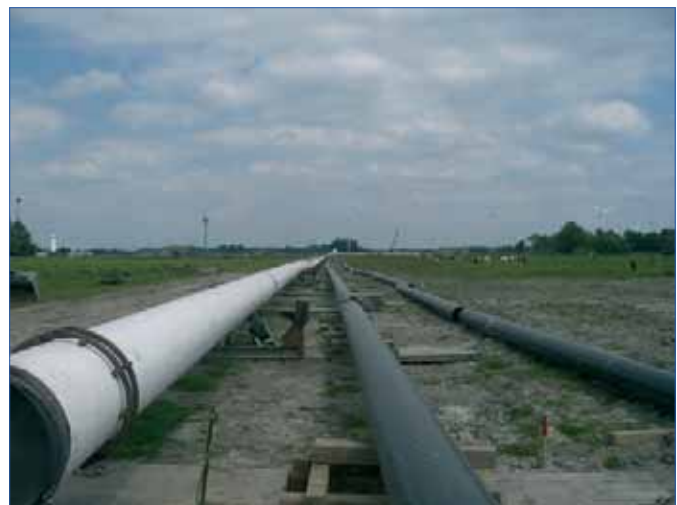
Abb. 2.: Geschweißte Rohrleitungen, Vorbereitung zum Einzug
