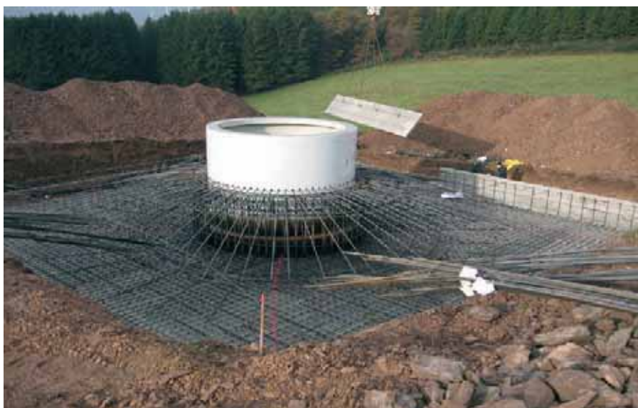
Abbildung 1: Fundament für eine Windenergieanlage
