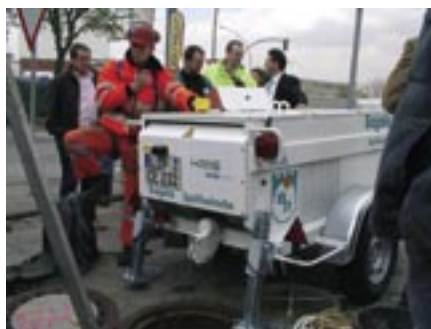
Seilwinde mit Zugkraftbegrenzer – Zielschacht.
