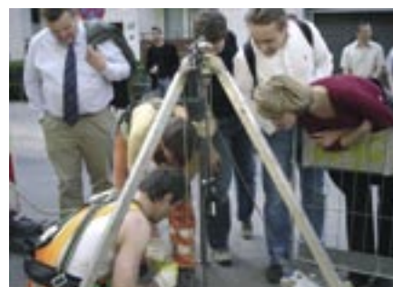
Probenahme im begehbaren Kanal.
