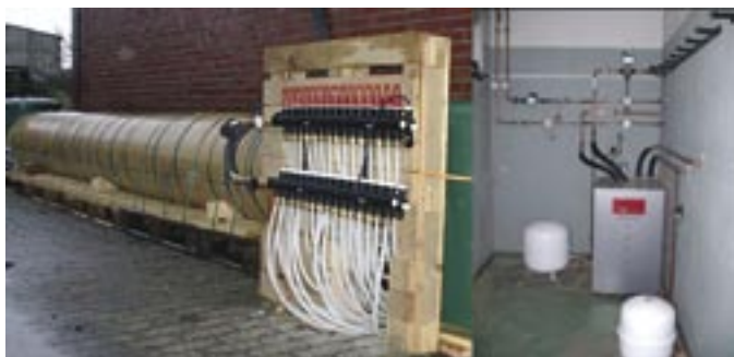
Abb. 1: Anschlussmontage Wärmetaucher.
