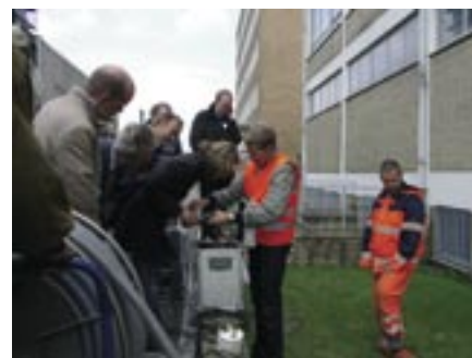
Fräsrobotertechnik bei der Hausanschlusssanierung.
