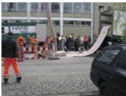
Sielsanierung in der Basedowstraße – Startschacht.
